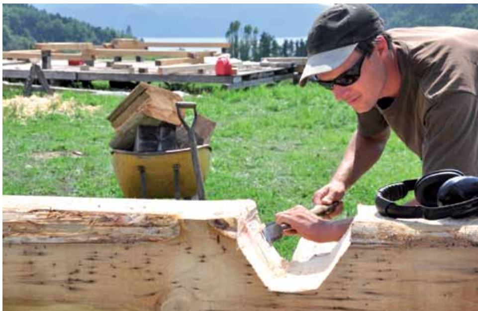
Installé en surplomb, le chantier des Artisans du fjord contemple le Saguenay.
